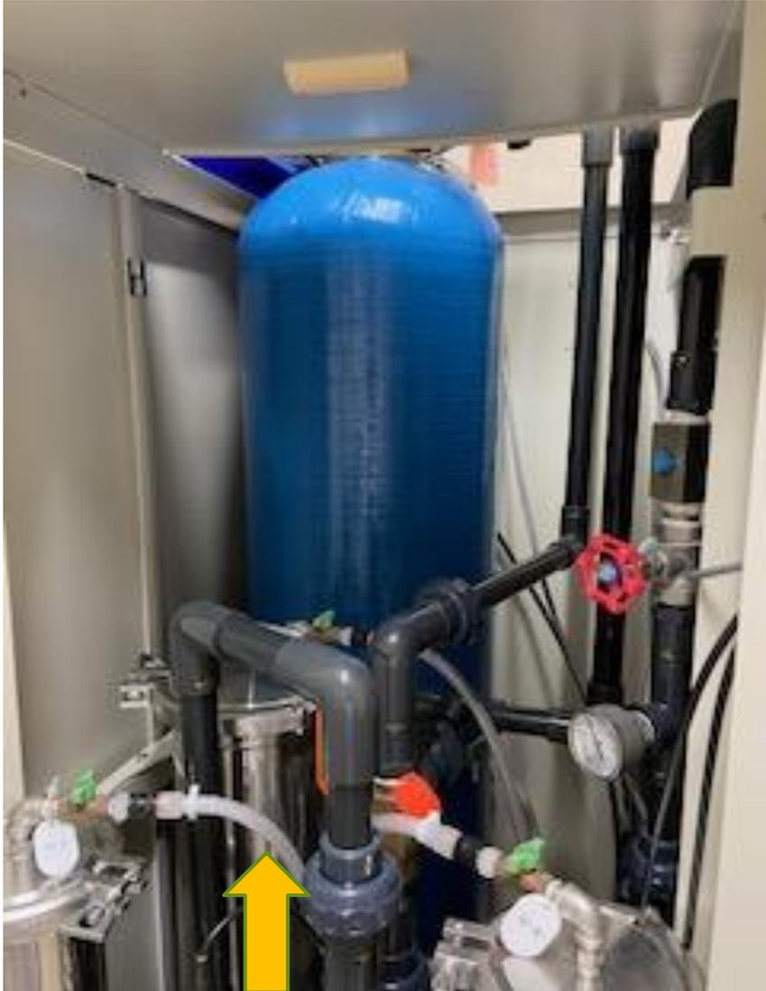
軟水装置を通過した軟水中の遊離塩素、クロラミンを活性炭により除去します。
