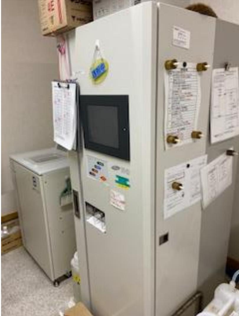
A原液、B原液にRO水を混合希釈しコンソールに供給する。希釈比は、以下に示す
